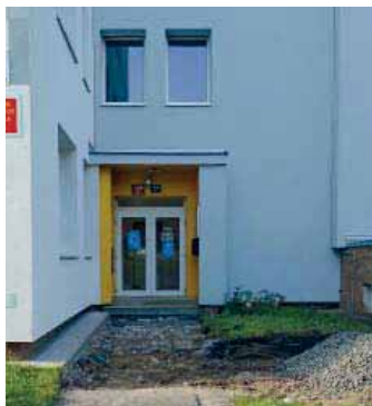
Chodník před rekonstrukcí
