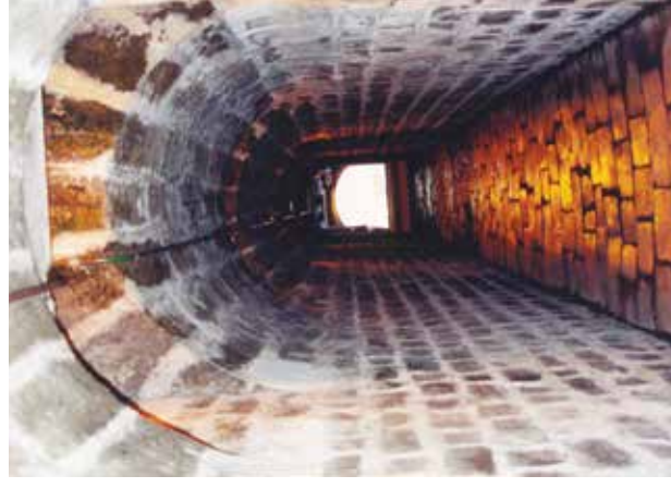
K nádražní budově ve Vysočanech je neobyčejný přístup – tunelem pro pěší a dvěma schodišti
