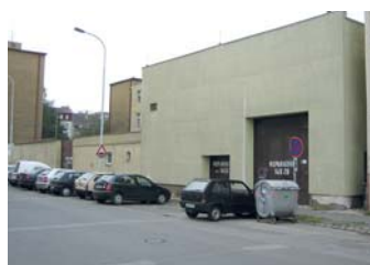
Budova C v roce 2005... a dnes
