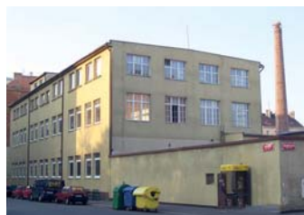
Budova D v roce 2005... a dnes
