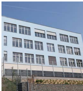
Nový školní pavilon v ZŠ Špitálská
