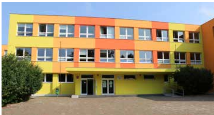
Zateplení ZŠ Novoborská
