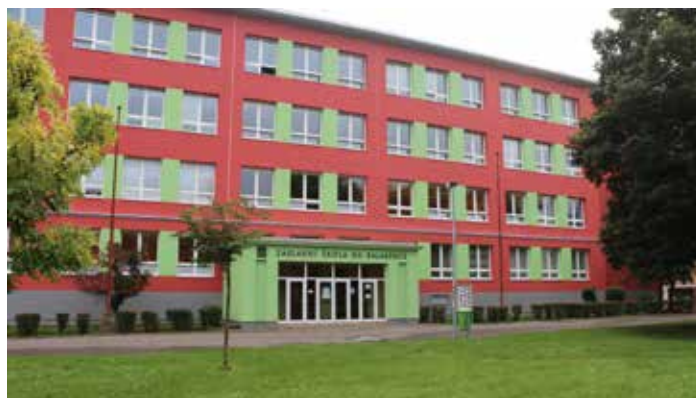
Zateplení ZŠ Na Balabence
