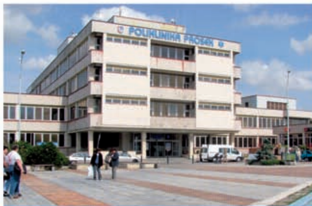
V první etapě rekonstrukce Polikliniky Prosek dojde k nástavbě jejího severního křídla. Dalším krokem v modernizaci prosecké polikliniky bude nástavba objektu, který dnes slouží Lékařské službě první pomoci.
