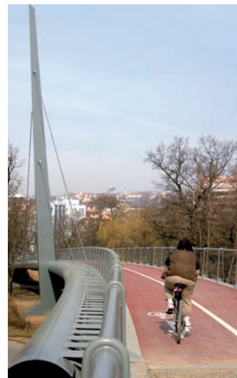
Po ocelové lávce u Freyovy ulice se cyklisté, bruslaři i rodiče s kočárky pohodlně dostanou na bývalý násep železniční vlečky, kudy dnes cyklostezka vede
