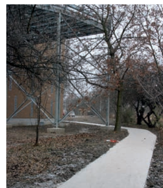
Kolem garáží nově vede chodník ze zámkové dlažby, který zkracuje místní cestu k zastávce autobusů na Prosecké ulici
