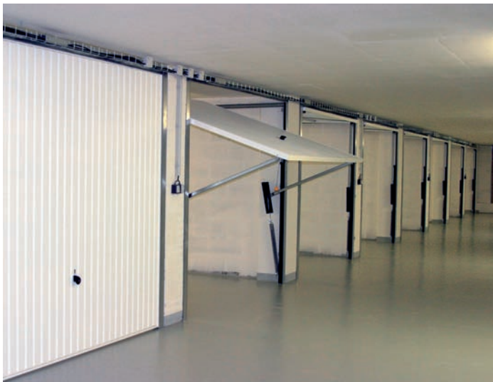
Nová stavba má 327 garážových stání
