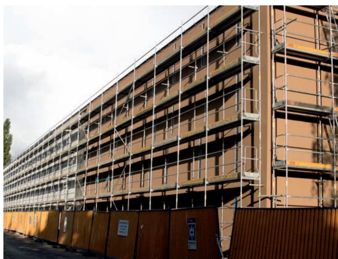
Poté, co stavbu převzala Městská část Praha 9, rostly garáže jako z vody. Stav v říjnu 2009.
